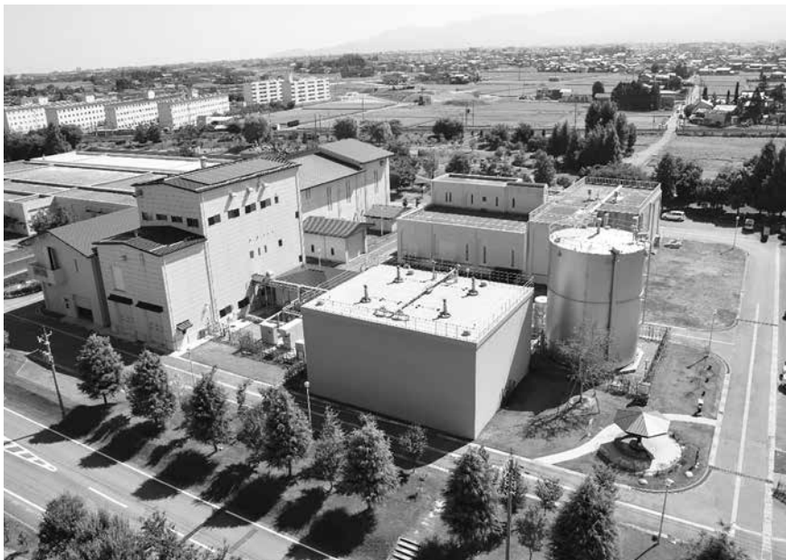
バイオマスエネルギー利活用施設 全景
