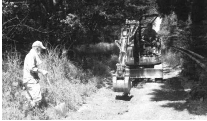
県境の車道整備
