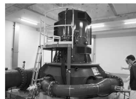
相ノ又谷水力発電所
