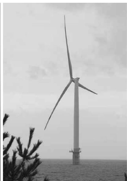
入善洋上風力発電所
