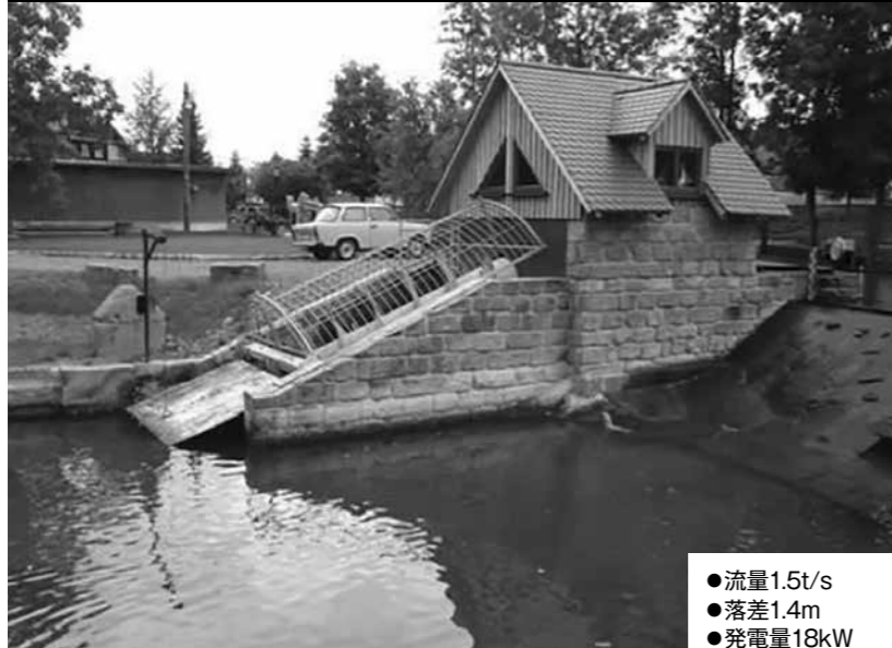
写真10 個人所有の小水力発電所 (ケーニツヒスホーフェン：タウバー川)
