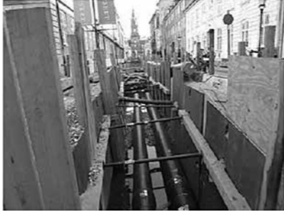
上右: Samsø島内に温水を供給する配管 上左・左下: コペンハーゲン市内でも、せっせと地下配管を進めている。
